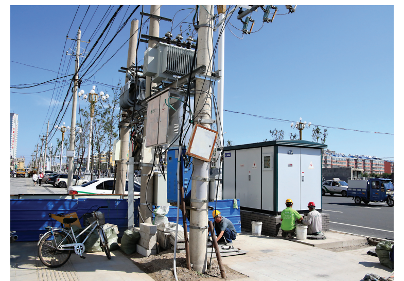
在市区主要街路上,管廊建设正在有条不紊进行。本报记者马彬摄
