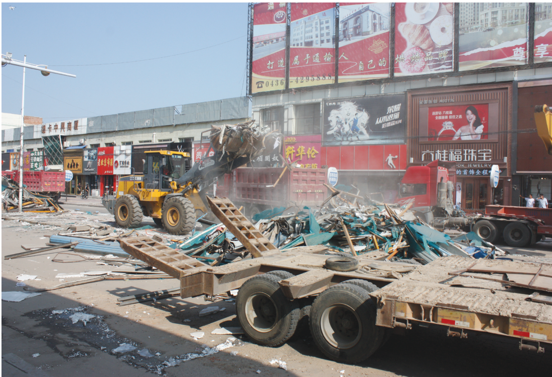
图为商贸长廊拆除现场。
