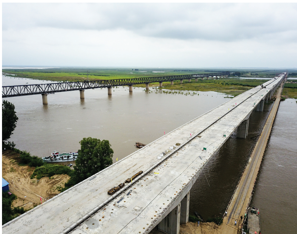
8月14日,嫩江公路大桥鸟瞰。经过两年多的建设,位于大安境内、横跨吉黑两省、总投资4.99亿元的嫩江公路大桥项目完成桥梁主体工程。
