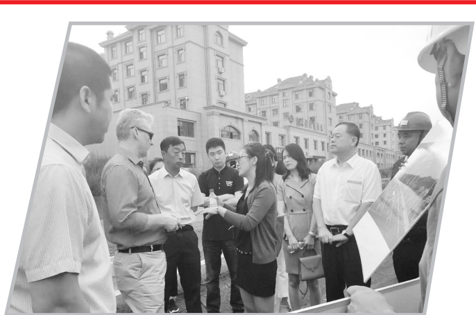
亚行检查团团长安德鲁·麦安久视察幸福北街施工现场。
