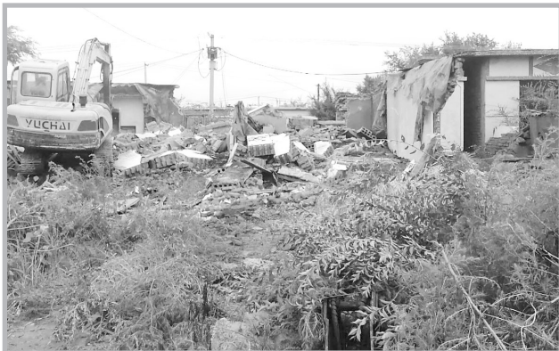
征地区域内房屋拆除。
