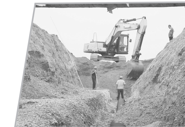
向阳街1标段雨污水管铺设施工现场。
