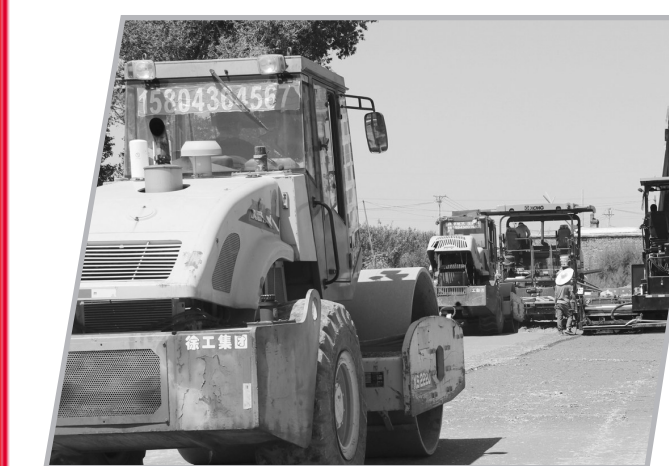
幸福北街水稳摊铺现场。
