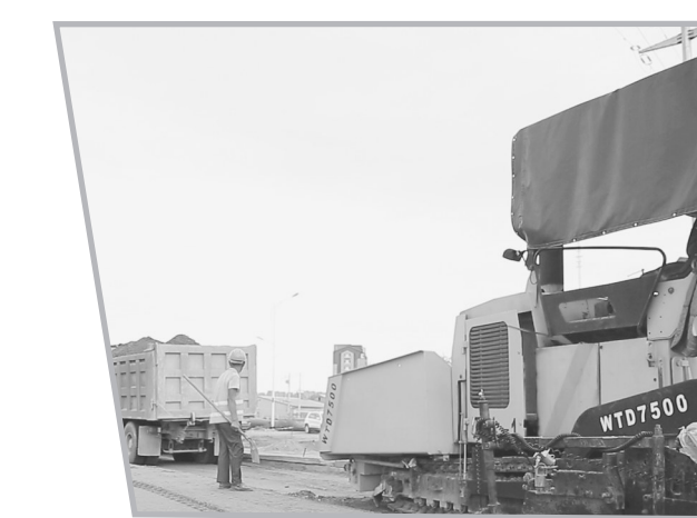
向阳环岛水稳摊铺现场。
