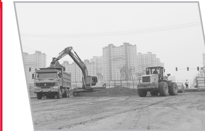
幸福北街施工现场。
