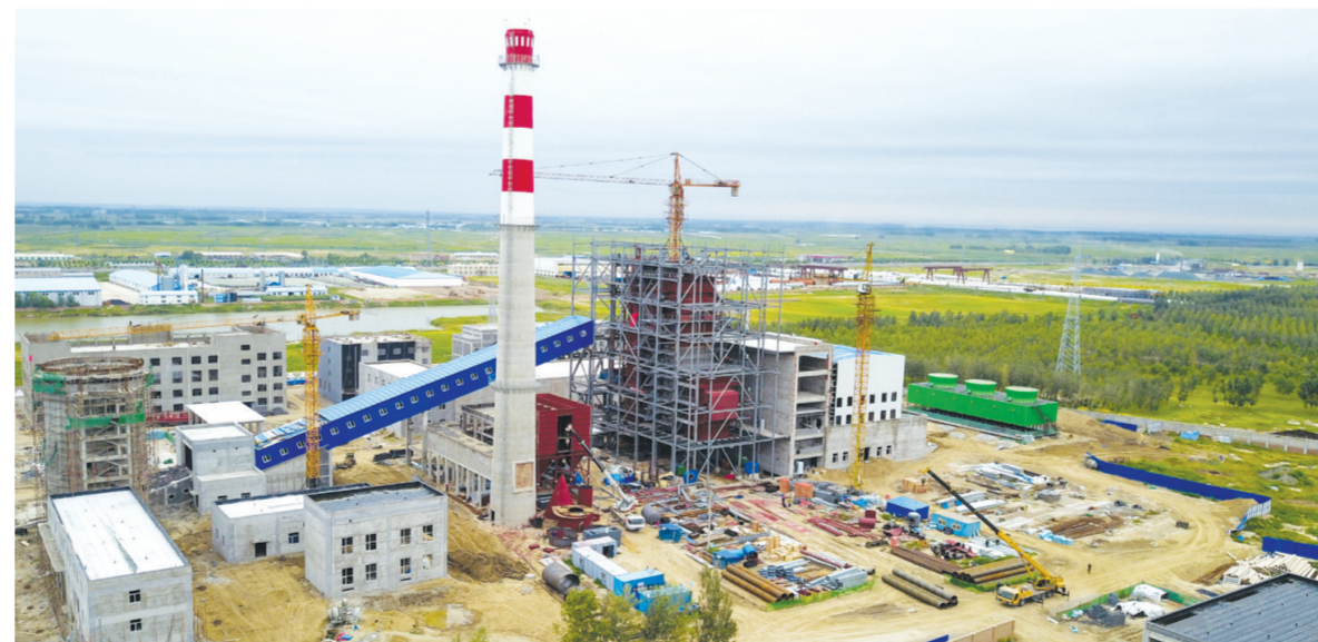
作为全国百个城镇生物质热电联产县域清洁供热示范项目之一，大安市安广镇生物质热电联产项目计划投资3.5亿元，每年可利用玉米秸秆21万吨，年发电量2.1万度，供热60万平方米，产值可达1.6亿元，并带动当地形成农林废弃物收购、储存、运输、深加工产业链条。据了解，该项目即将投产。
