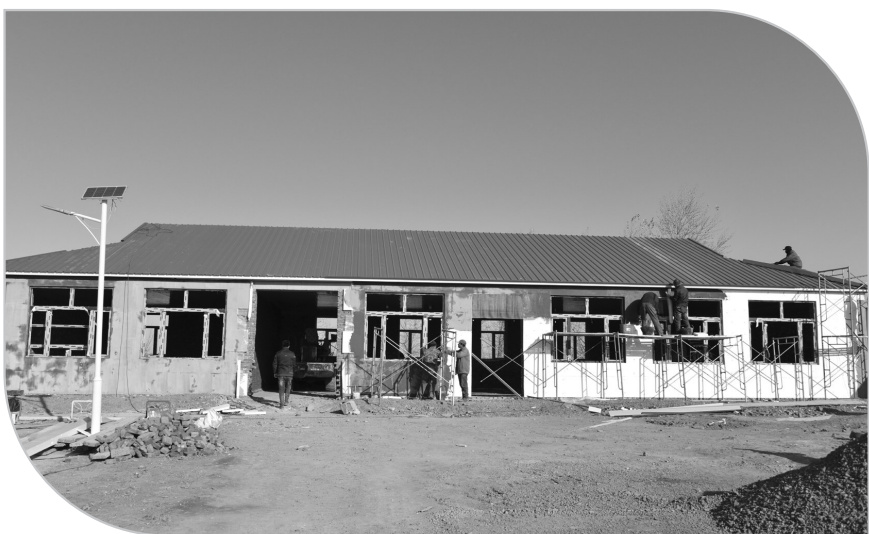
正在建设中的金祥乡保安村村部。
