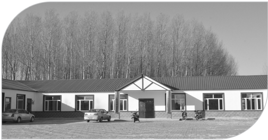
建成并投入使用的洮河镇楚伦村村部。
