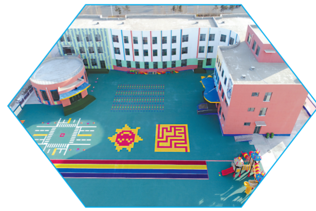
新建基础教育设施
