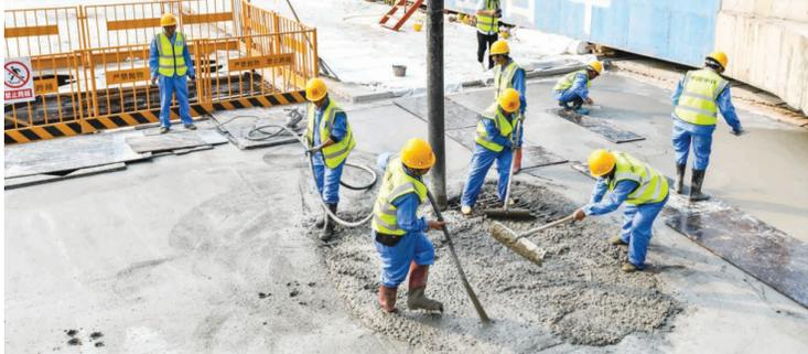
3月26日，工人在深圳前海蛇口自贸区10号冷站进行最后一块顶板混凝土浇筑。当日，由中国中铁承建的深圳前海蛇口自贸区10号冷站顺利封顶，该冷站占地面积9200平方米，供冷面积约100万平方米。深圳创新绿色发展模式，以建设“超级空调”——冷站集中供冷的方式取代传统楼宇各自供冷模式，构建清洁低碳、安全高效的能源体系。
