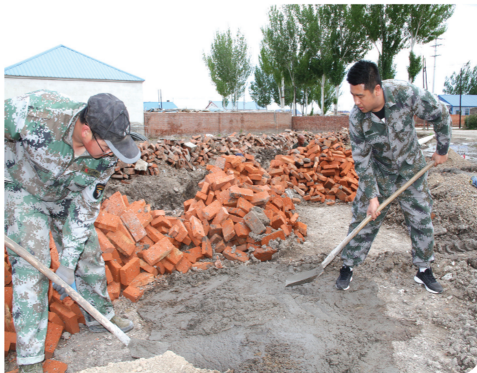
县水利局干部在包保的五棵镇镇五棵村村修筑排水渠,解决排水难题。 宋磊摄
