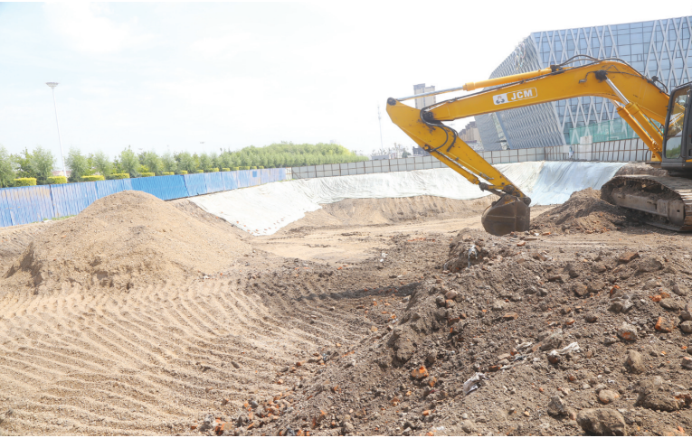
图为阳光广场内施工现场。
