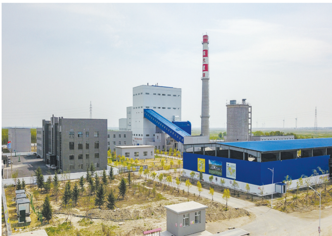
作为全国百个城镇生物质热电联产县域清洁供热示范项目之一,总投资3.1亿元的大安市安广镇生物质热电联产项目一期主体工程已全部完工。项目投产后,每年可利用玉米秸秆21万吨,年发电量2.1亿度,产值可达1.6亿元。 刘大易 本报记者李晓明摄
