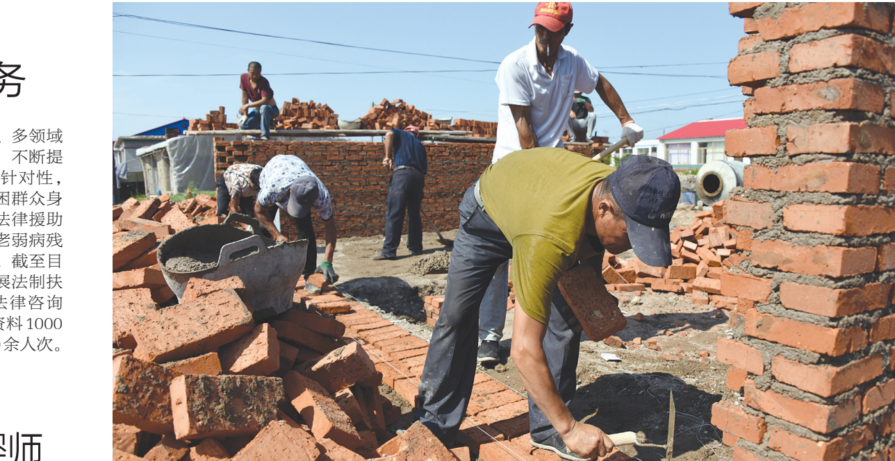
今年年初以来，洮北区围绕脱贫攻坚这条主线，充分利用农村危房改造这一惠民政策，紧紧抓住当前施工黄金期，倒排工期、挂图作战，全力以赴推进农村危房改造工作，确保早日让贫困群众住上“放心房”“满意房”，提升贫困群众幸福指数。图为德顺蒙古族乡德顺村危房改造施工现场。王维俊 本报记者张殿文摄
