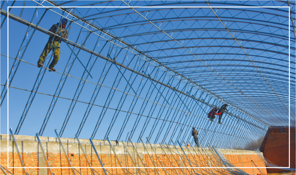
今年10月份开工建设、总投资350万元的白城市大陶河苏蔬菜种植专业合作社温控大棚建设项目,位于洮北区德顺蒙古族乡洮河村,项目占地2.6万平方米,建有8个温控式大棚,建筑面积5760平方米,项目建成后可带动洮河村贫困户80户163人,每人每年预计分红300元。图为项目施工现场。
