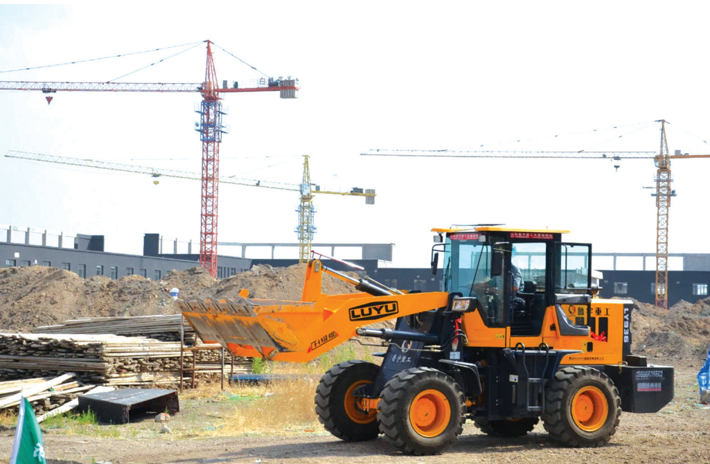
5月15日，白城中农国际农副产品批发市场项目二期工程正式复工。目前，项目正在施工的是市场内的道路及B2沿街商铺和市场配套曙光路的修建工作，预计10月份左右水果和蔬菜交易区投入试营业。 姚宣摄
