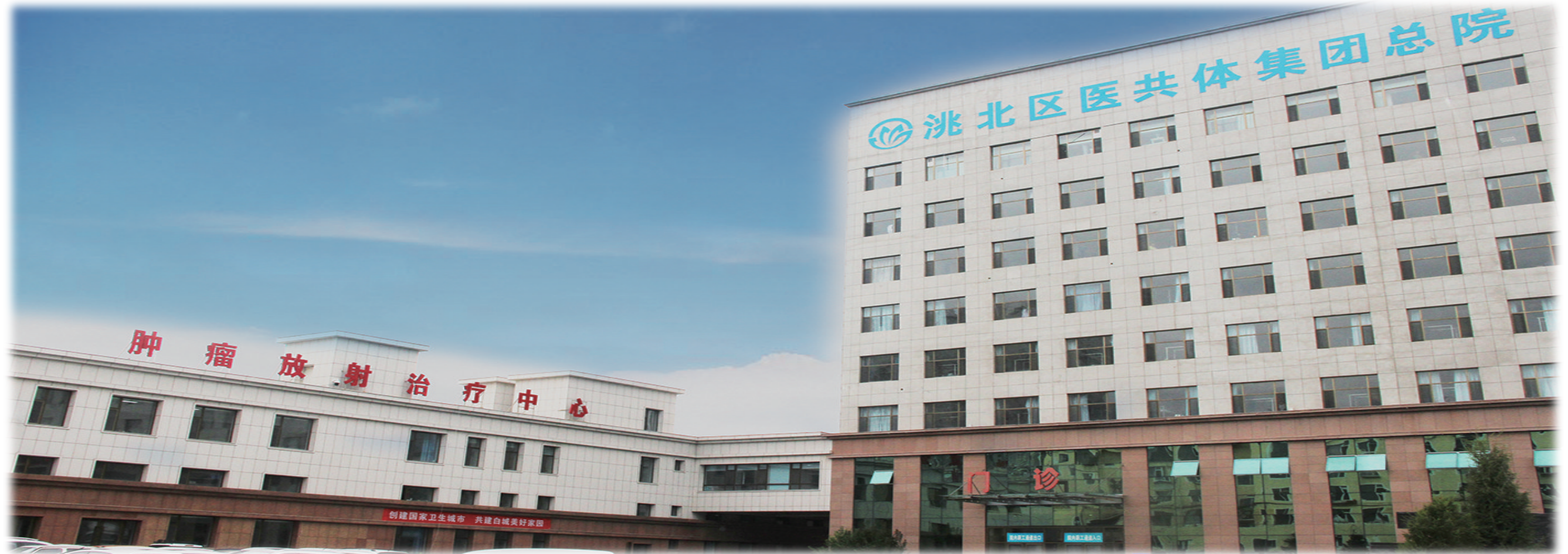
白城市医院肿瘤放射治疗中心医疗综合楼。
