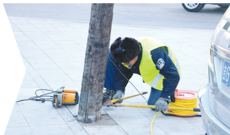
市政工人正在拆除旧线杆。
