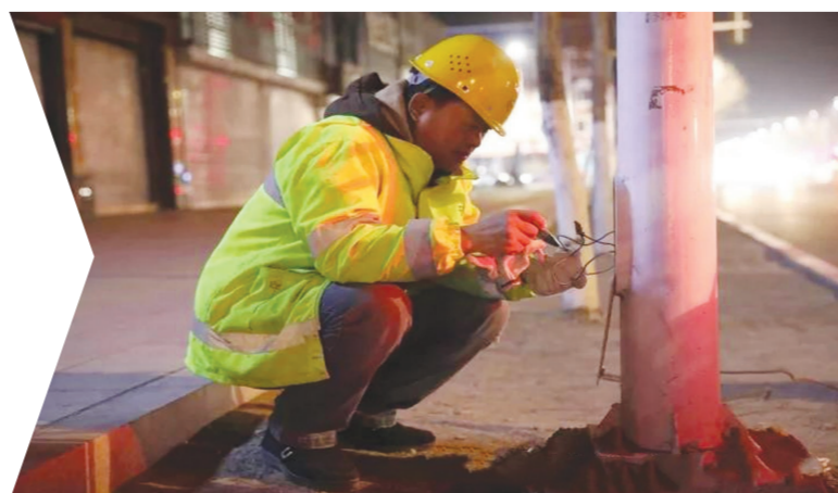
市政工人正在维修路灯。
