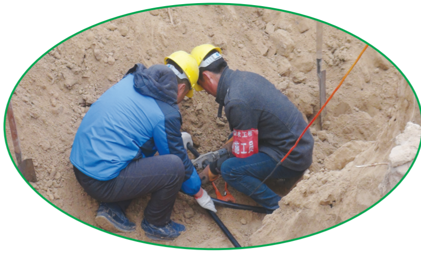
农村饮水安全工程施工人员在进行管网的连接施工。
