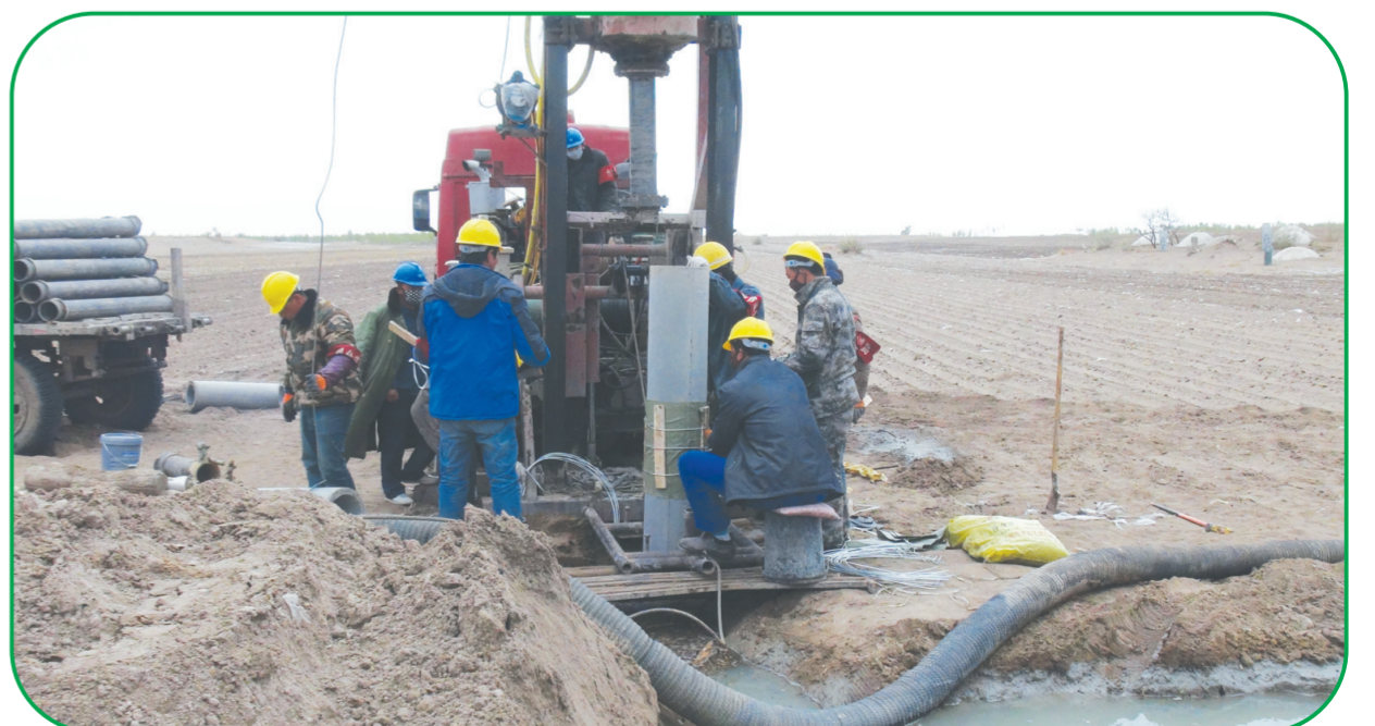
农村饮水安全工程水源井施工现场。
