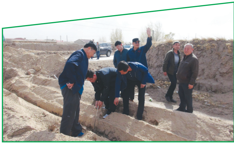
农村饮水安全工程各参建单位测量管网埋深,确保管网深度满足设计要求。
