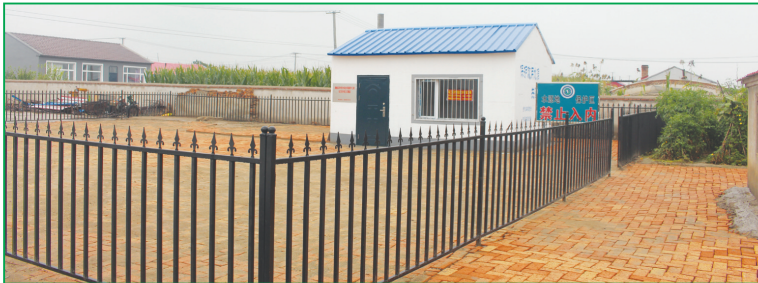
脱贫攻坚期间,通榆县乌兰镇乌兰花村对饮水安全巩固提升工程管理房进行了维修加固,并设置了工程围栏。
