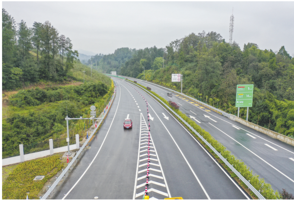
当日，由贵州桥梁建设集团承建的重庆市南川区至两江新区高速公路（简称“南两高速”）正式通车（五台收费站以北约2.4公里暂不开通）。南两高速于2016年底开工建设，全长约77公里，途经南川、涪陵、巴南、渝北四个区县，是重庆市“交通建设三年行动计划”重要项目。
