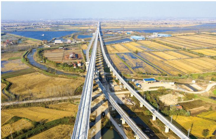
安九高铁湖北段无砟轨道施工全面展开 中铁十一局承建的安九高铁长江特大桥（北引桥），已完成双向6公里的无砟轨道板铺设（11月18日摄，无人机照片）。 目前，经过参建者艰苦奋战，安九高铁湖北段无砟轨道全面展开施工。安九高铁（安徽安庆至江西九江）正线全长198.3公里，其中湖北段51.1公里。 新华社记者杜华举摄
