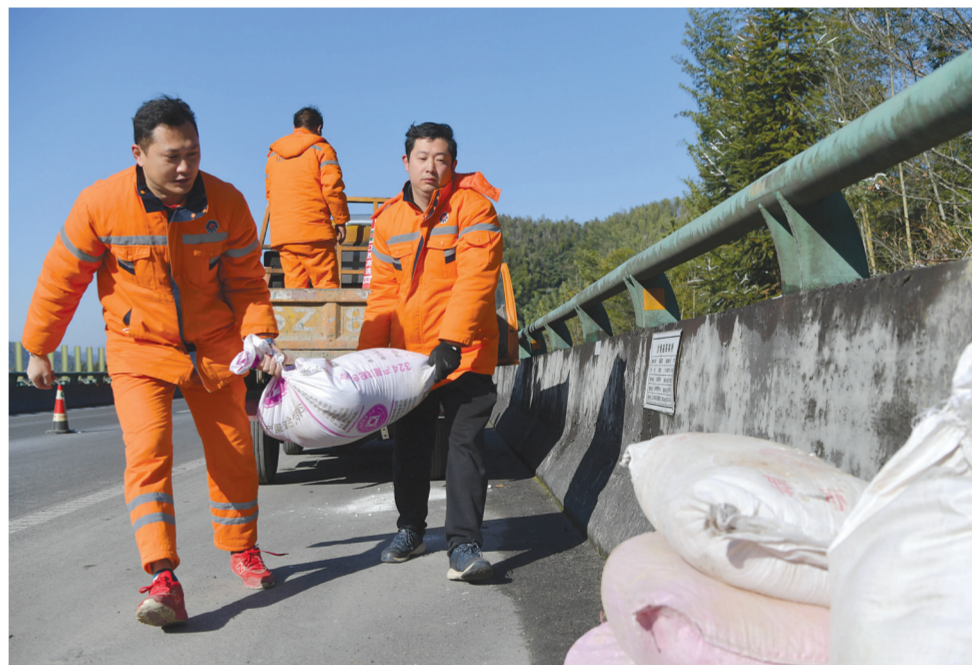
1月8日，在福银高速温沙段桃木岭大桥，江西省交通投资集团抚州管理中心南城养护所的工作人员在搬运除冰雪用的工业盐。连日来，为应对强寒潮天气，江西省交通投资集团各管理中心积极备战，在易结冰的桥梁路段提前放置安全锥、警示牌、工业盐等物资，强化24小时不间断高速公路巡查、除冰、排险，确保省内各条高速公路平安畅通。新华社记者彭昭之摄
