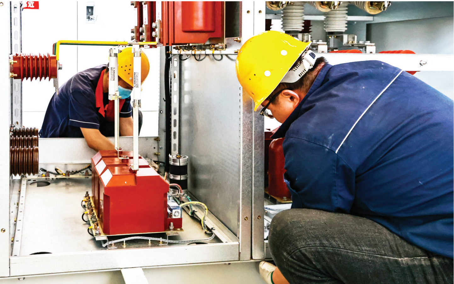
镇赉县成来电气科技有限公司成立于1970年，现已发展为总占地面积25万平方米，员工370人，拥有各种生产及检测设备400余台(套)、年生产输变电设备能力2000万千伏安以上、风力发电机机舱罩1600台(套)，年产值4.2亿元的科技创新型集团性企业。目前，已成功进入中水、国电投、三峡集团、中广核集团、华能集团、大唐集团、中节能、中国电建、国家电网等大型发电集团合格供应商名录，并逐步占领西北、华东、华北光伏等发电市场，实现新能源市场全国性市场突破。图为工人正在检修设备。
