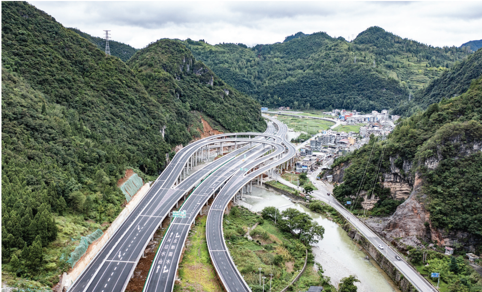
8月15日拍摄的秀印高速公路木黄互通（无人机照片）。当日，秀山至印江高速公路（贵州段）正式通车，项目全长52.896公里。秀印高速建成后将成为黔东北连接成渝经济圈的快速通道，将在推动武陵山片区三省市交界经济融合发展等方面发挥重要作用。
