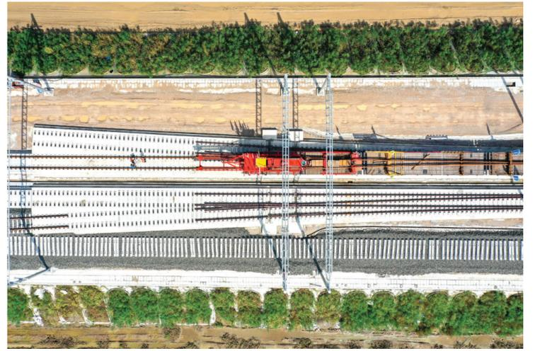
9月27日,铺轨机在京唐城际铁路铺轨现场作业(无人机照片)。当日,中铁四局工作人员驾驶铺轨机在京(北京)唐(唐山)城际铁路施工现场开始进行长轨铺设,标志着京唐城际铁路进入铺轨阶段,为下一步静态验收及京唐城际铁路按期开通奠定坚实基础。京唐城际铁路起点位于北京市通州区的城市副中心站,终点位于河北省唐山市唐山站,线路长约148.74公里,最高设计时速为350公里。新华社记者牟宇摄
