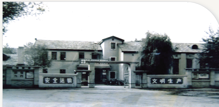
辽吉省委旧址旧貌
