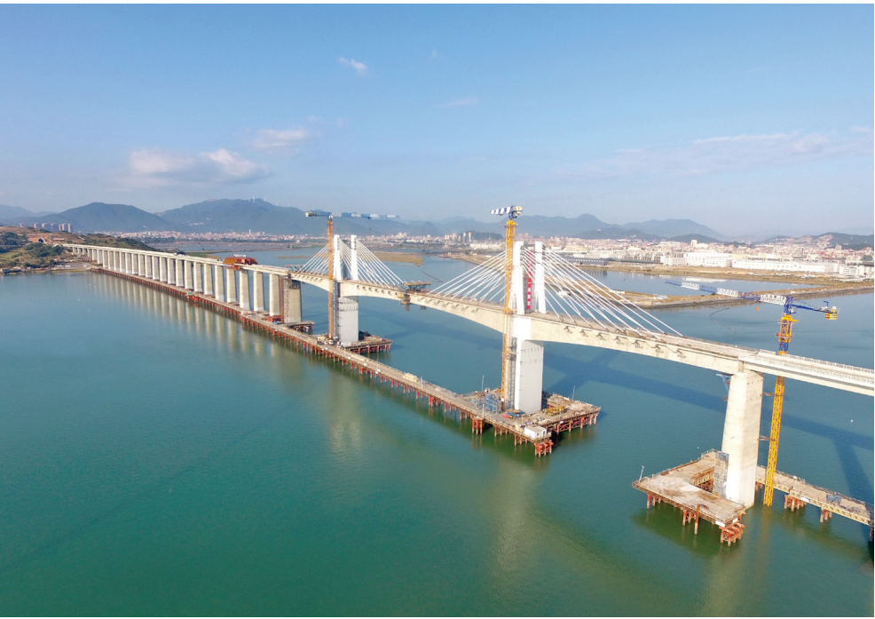
这是11月13日拍摄的建设中的新建福厦铁路泉州湾跨海大桥（无人机照片）。当日，由中铁十一局承建的新建福（州）厦（门）铁路泉州湾跨海大桥成功合龙，标志着新建福厦铁路关键控制性节点顺利打通，为如期建成通车打下坚实基础。 新建福厦铁路泉州湾跨海大桥长14.7公里，海域施工长10.8公里，主桥为主跨180米的矮塔斜拉桥，是国内首座跨海高铁矮塔斜拉桥。 新华社记者林善传摄
