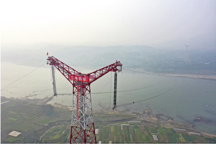
12月5日，在白鹤滩—江苏±800千伏特高压直流输电线路工程（重庆段）江津长江大跨越施工现场，工人在长江上空作业（无人机照片）。
