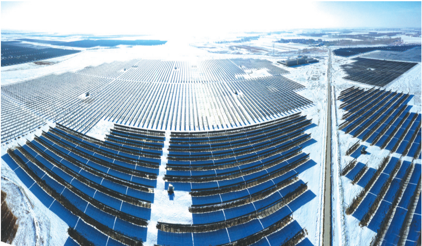
通榆县光伏项目2014年初由国家核准制改为备案制，2015年4月首次获得国家光伏项目建设指标。截至目前，该项目并网装机容量为53万千瓦，所有项目全部正常运营、投产达效。其中，光伏普通电站10.5万千瓦、光伏领跑者基地项目30万千瓦、光伏扶贫项目装机容量为12.5万千瓦。图为通榆县光伏项目现场。
