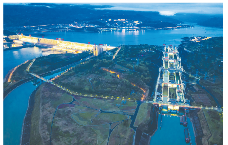
3月22日晚拍摄的三峡大坝和三峡五级船闸夜景(无人机照片)。当日20时，三峡南线船闸2022年计划性停航检修圆满完成，提前12小时恢复通航。
