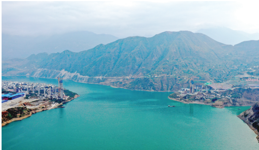
这是11月23日拍摄的卡哈洛金沙江大桥施工现场(无人机照片)。
