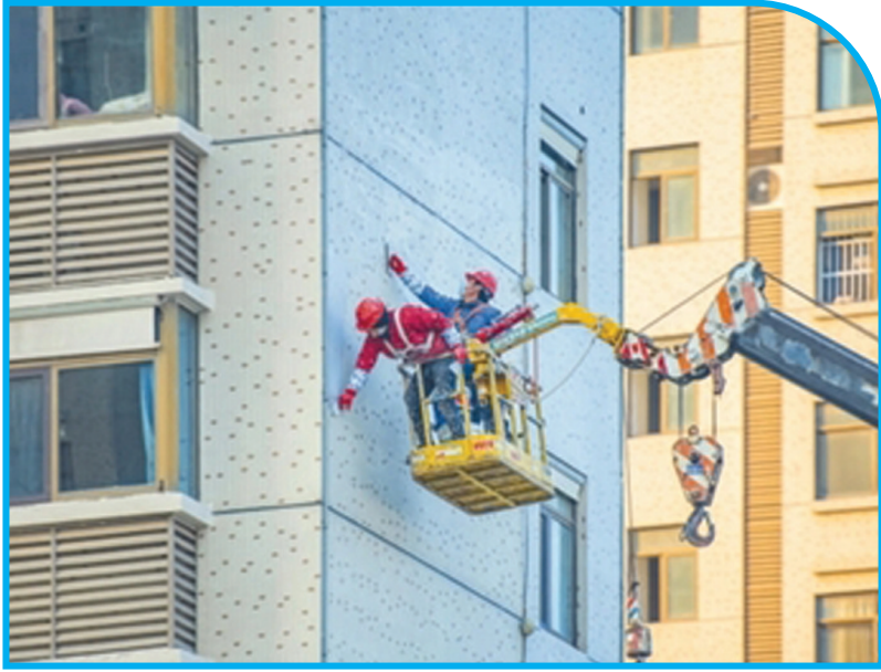
在江苏宿迁宿城区古城街道府前社区,工人正对小区外墙实施修补防水作业。 魏琦原摄(影像中国)
