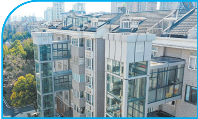
安徽合肥蜀山区琥珀街道一老旧小区通过加装电梯有效改善居民居住条件。 陈三虎摄(影像中国)
