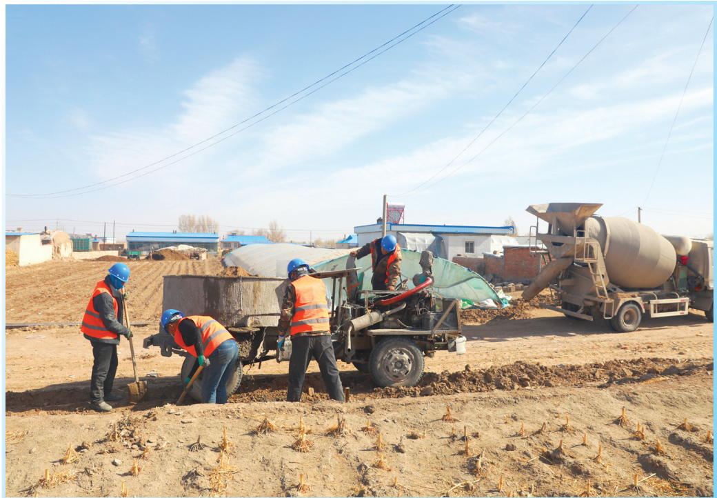
前不久，洮南市蛟流河乡志强村启动“千村示范”创建工作，围绕创建标准稳步推进各项建设，进一步改善人居环境。图为施工现场。
