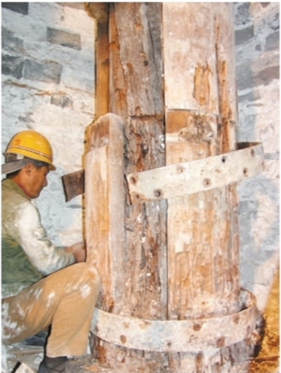
故宫太和殿内,施工技术人员正在揭露严重糟朽的柱根。
