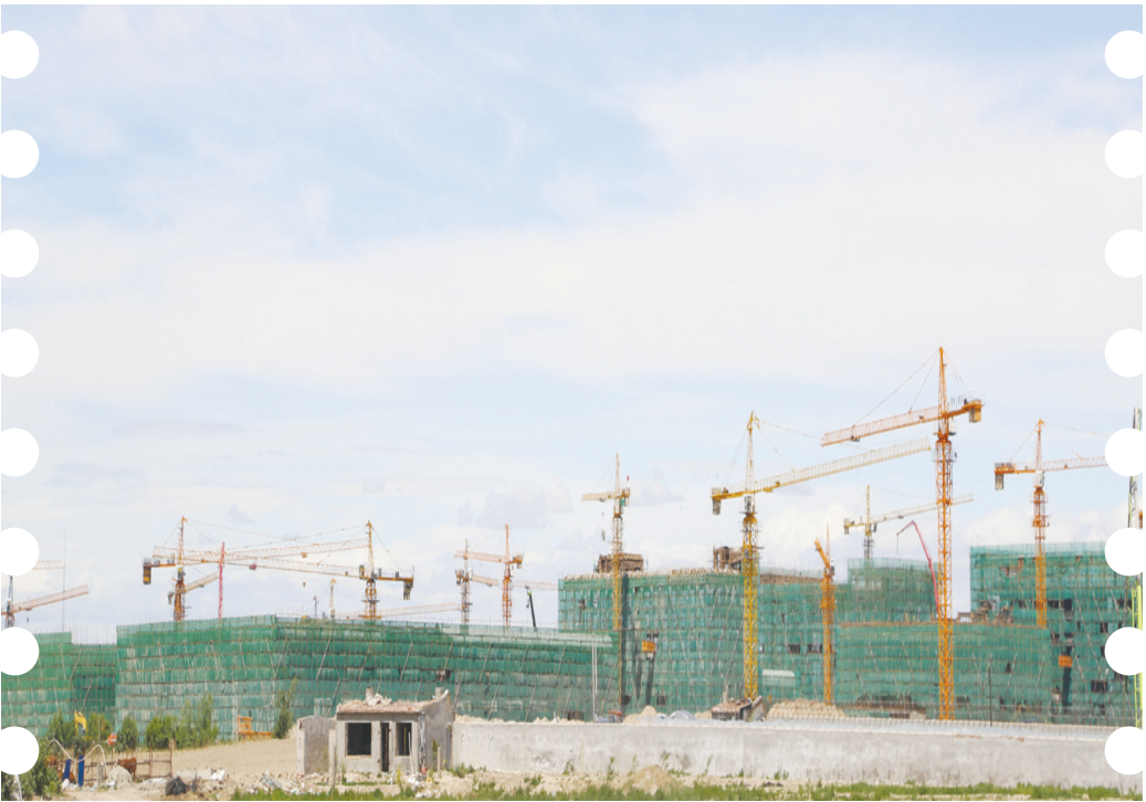
今年，总投资11亿元的通榆县农产品融合发展示范项目开工建设，预计2024年12月竣工。这个项目前端种植可带动万亩基地，近万户农民可采取订单式种植；中端生产可实现一产到二产的产能转化，提升农作物精深加工的附加值；后端可通过吉林省润泽农业发展有限公司联接通榆县172个行政村入股经营，实现产业分红，增加农民收入。图为项目施工建设现场。
