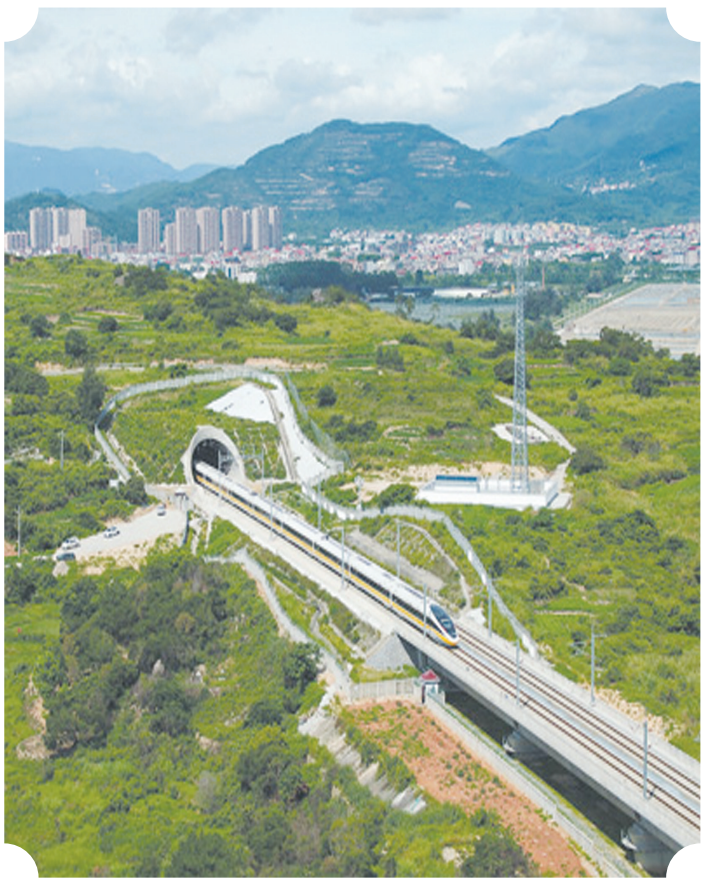
CR450 新一代动车组试验列车驶过福厦高铁福清至泉州区段海尾隧道。
