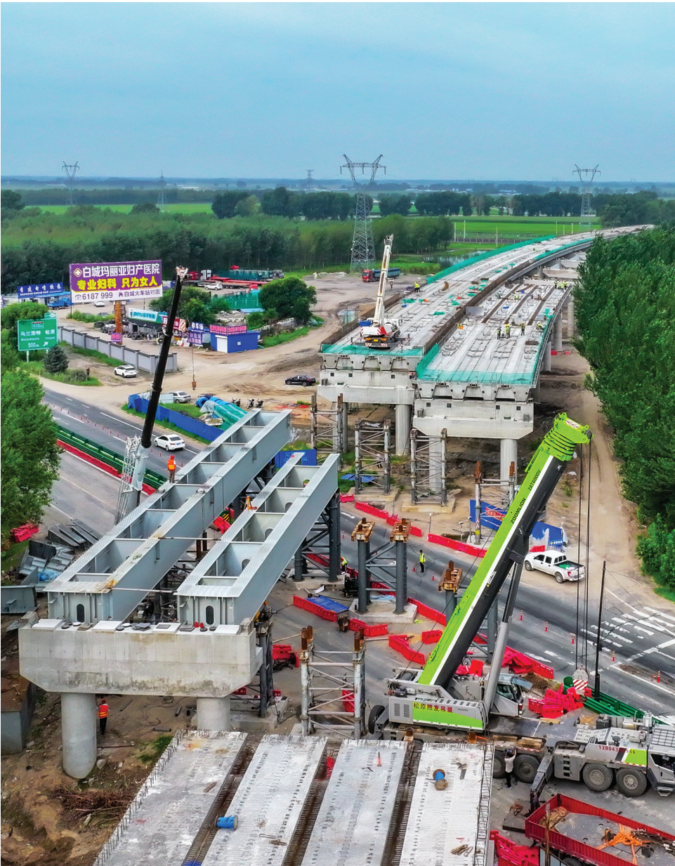
目前,国道珲阿公路与平齐铁路和国道嫩双公路交叉改造工程项目正在火热建设中。截至8月1日,已完成项目所有工作的54%,预计12月底通车。图为施工进入上部结构和箱梁架设阶段。本报记者李晓明摄
