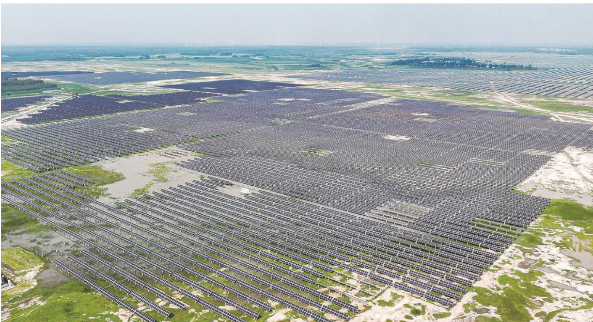
近年来,我市大力发展新能源产业,全力推进“陆上风光三峡”建设,在通榆、大安、镇赉、洮南等地建设了白城光伏领跑者奖励基地。图为通榆县鸿兴镇绿化村鸿兴项目区光伏设施。张野 钱文波 摄
