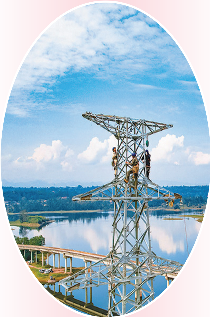
重庆市长寿区洪湖镇，国网重庆长寿供电公司的检修人员正在作业。 黄培摄(影像中国)
