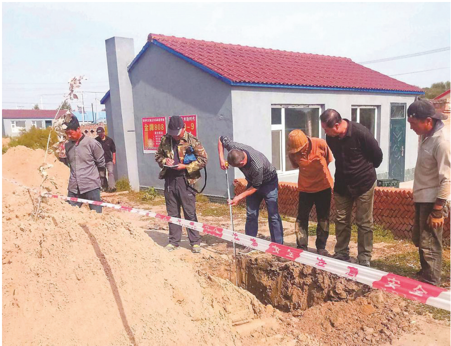
镇赉县推进农村供水工程。图为维修工人维修供水管网。（资料图片）
