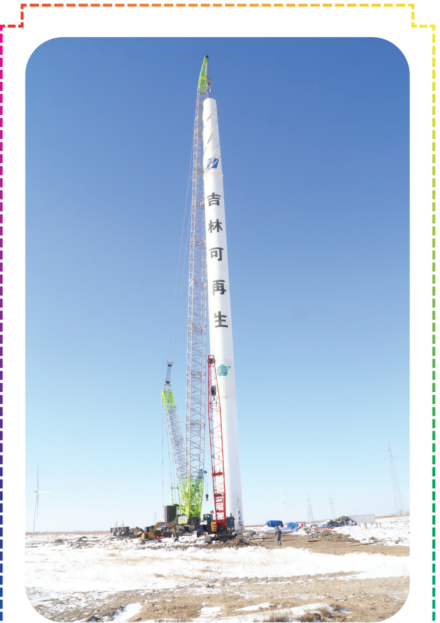
吉能通榆八面风电项目总装机30万千瓦,预计每年可为电网提供稳定的清洁电能近10亿kWh,项目建成后,将有效改善吉林省500千伏“两横两纵双环网”电网结构,满足西部地区新能源开发需求,提高东西部电网互济能力,发挥资源利用、节约能源示范作用,对带动地方经济快速发展将起到积极作用。图为风机吊装的场景。
