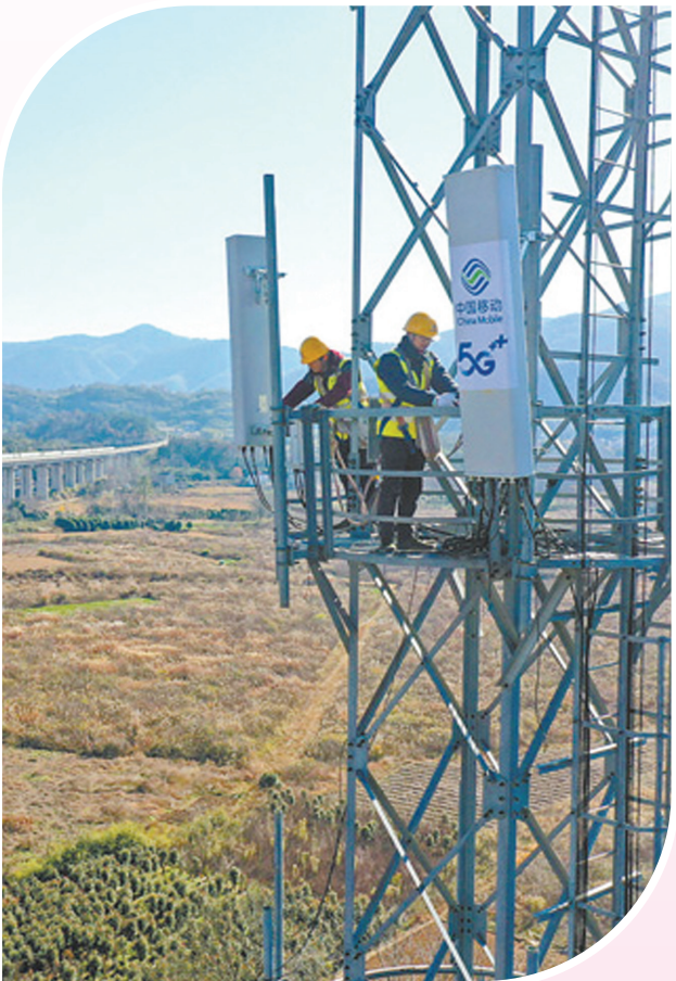
安徽移动铜陵分公司施工人员在合福高铁（铜陵段）沿线通信基站上调试5G专网设备。
