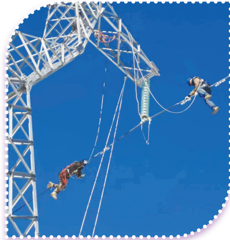
通榆境内220千伏某输电线路全景检修更换。岳星作摄
