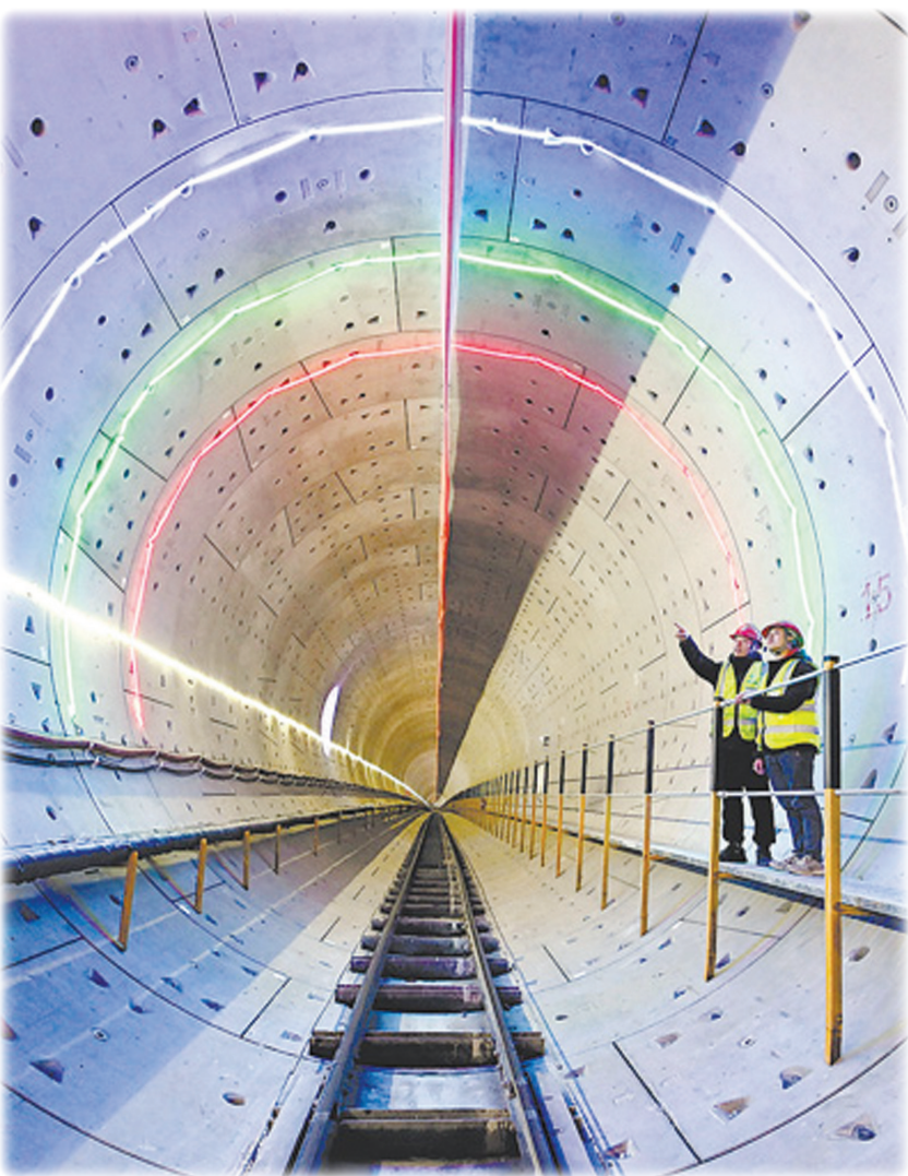
北京轨道交通22号线河北段盾构隧道内，工作人员在进行巡查。 新华社记者 王晓摄
