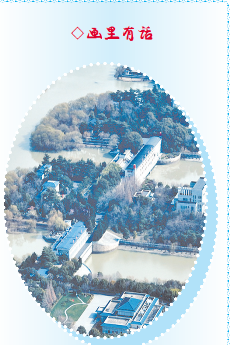
江苏扬州江都水利枢纽是南水北调东线工程的源头。图为江都水利枢纽局部。
