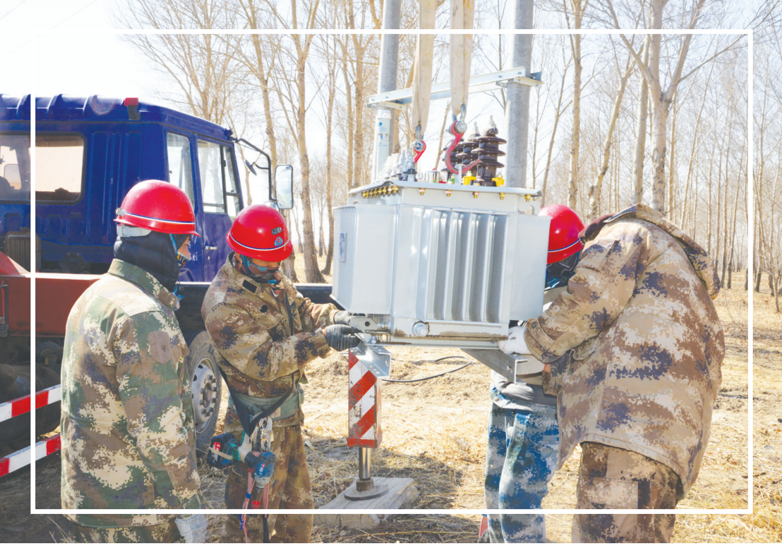
在通榆县十花道乡光辉村高标准农田建设项目施工现场，施工车辆来回穿梭，工人们各司其职，各项建设项目有序推进，呈现出一派繁忙景象。今年以来，通榆县抢抓春耕前农田建设“黄金期”，加强统筹协调，科学规划设计，全力推进高标准农田项目建设。图为施工单位正在安装电力设备。 陈宝林摄
