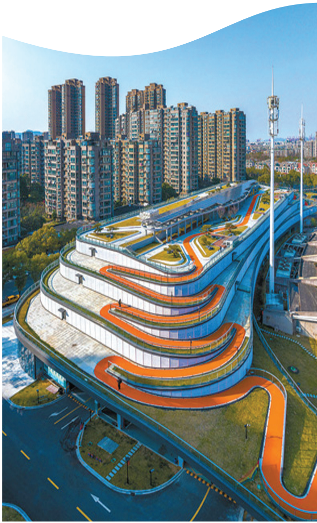
浙江省宁波市北仑区,体艺中心的立体停车场充电站可同时满足104辆车充电。 胡学军摄(影像中国)
