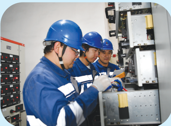
吉电股份白城发电公司设备部配电班对一次风机电机进行加装变频改造。
