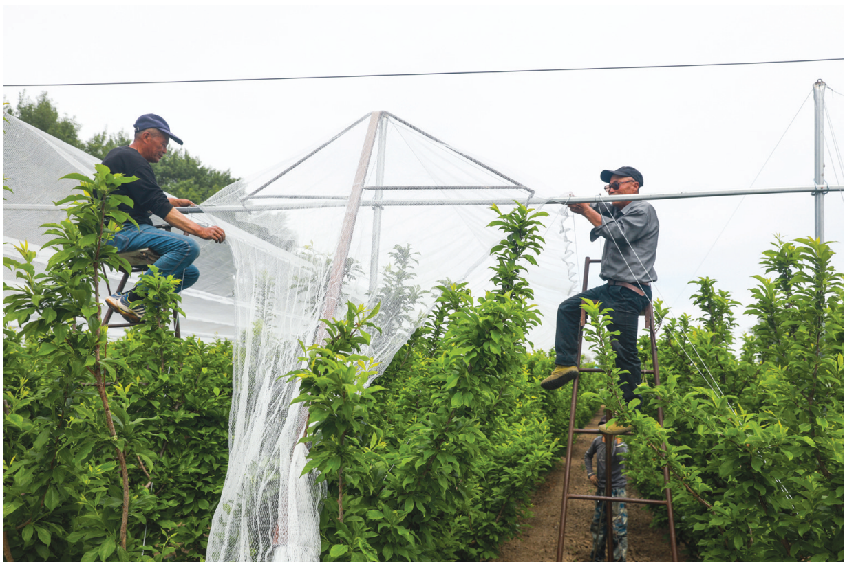
洮南市洮府街道南郊村刘重阳果园为应对可能发生的冰雹灾害，积极筹资建设防雹网，确保果品安全采收，免受灾害损失。图为施工挂网。 邵会宁 范海辉摄
