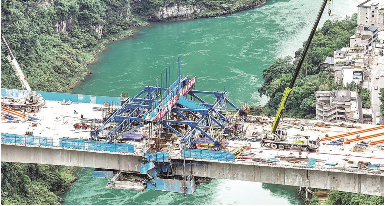
这是6月9日拍摄的渝湘复线高速磨寨乌江特大桥建设现场(无人机照片)。近日，位于重庆市彭水苗族土家族自治县境内的渝湘复线高速磨寨乌江特大桥进入最后一节2米连续梁浇筑施工作业，该桥即将实现全桥合龙。磨寨乌江特大桥由中铁建重庆投资集团有限公司投资、中国铁建港航局集团承建，桥梁全长708米、主跨296米。渝湘复线高速总里程280公里，平均桥隧比80%。今年内渝湘复线高速巴南至武陵段、彭水至酉阳段将建成通车，2025年有望全面建成通车。新华社记者唐奕摄
