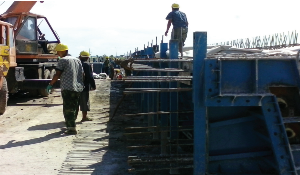
今年,通榆县加大了农村各地的道路桥梁建设力度,快速推进社会主义新农村建设步伐。图为正在施工中的通榆至大安线X113桥现场。 张军 智刚摄
