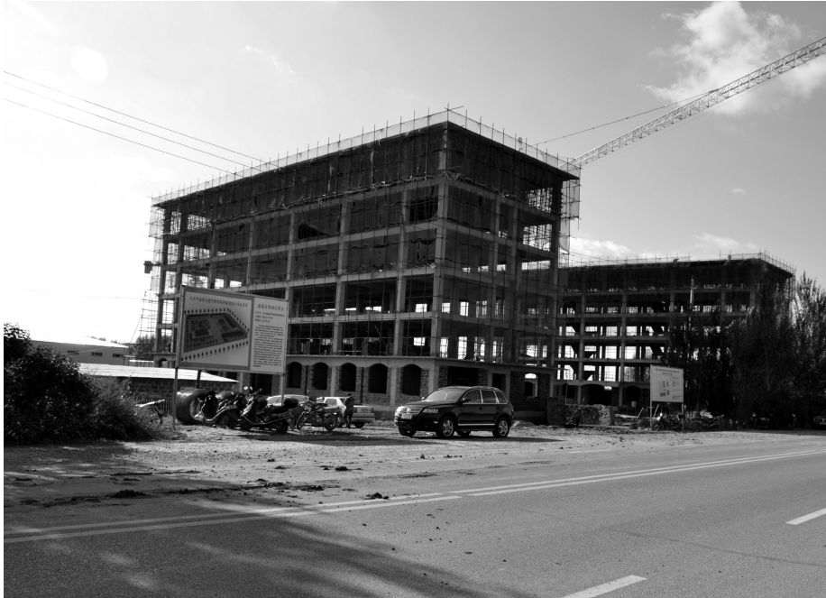
项目工程正在建设中。
